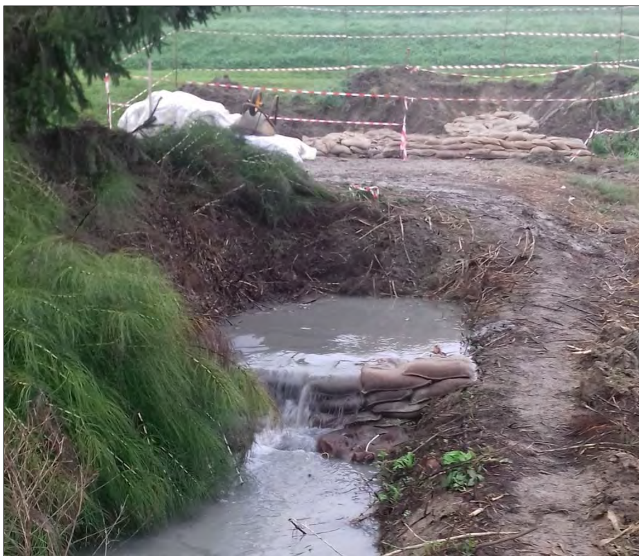
Figura 3 – Località Cavanella Po - Novembre 2018 - Coronella di sacchetti nel fosso di scarico del drenaggio, sullo sfondo è visibile il cedimento del piè di banca
